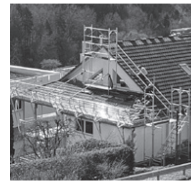
Der Zugang aufs Süddach erfolgte von Norden her.
