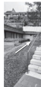
Der Zugang zu den Odd Fellows (Pfeil).
