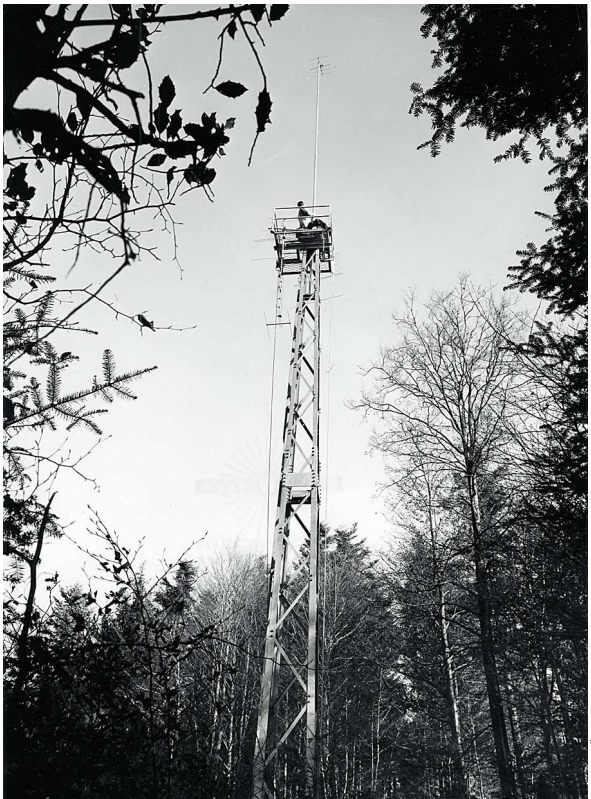
Empfangsstation der ersten breitbandigen Kabelfernseh-Anlage der Schweiz auf dem Waldgrundstück von Bauer Lustenberger, 1965.
